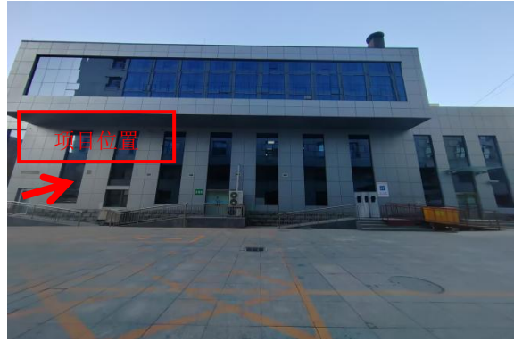
图 2-6 医院综合楼照片
