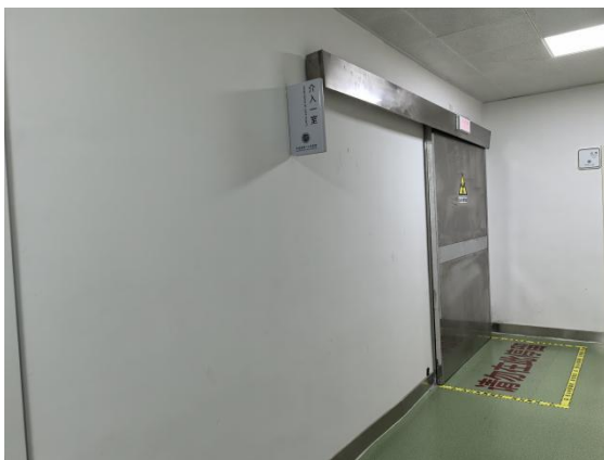
图 3-14 介入一室机房门工作状态指示灯和电离辐射标志
