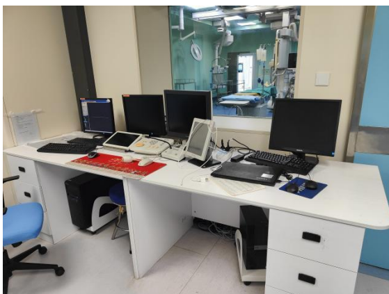
图 3-12 27 号手术室控制室、观察窗
