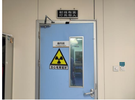
图 3-15 28 号手术间医护人员防护门、电离辐射警告标志、工作状态指示灯
