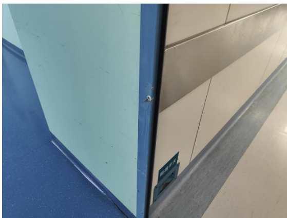
图 3-10 27 号手术室患者进出防护门红外防夹装置
