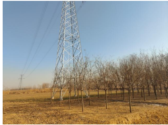
图 6-20 牵张场和临时道路周围临时占地恢复情况 4
