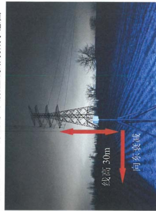
图 21 220kV 时宏线三回架空线路衰减示意图
