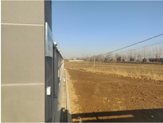
图 4-4 开关站东南侧围墙外空地
