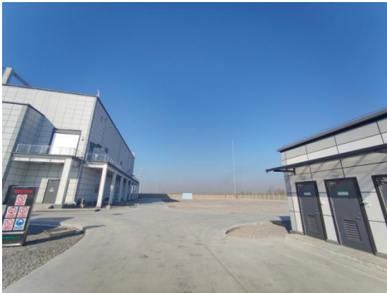
图 6-1 站内路面硬化
