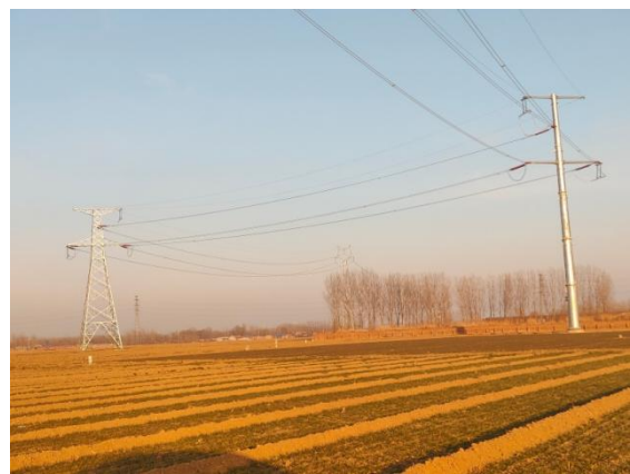
图 6-22 牵张场和临时道路周围临时占地恢复情况 6
