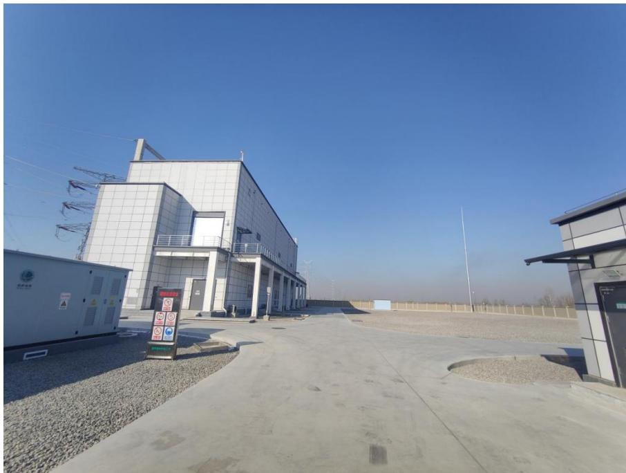
图 4-8 220kV 宏智开关站
