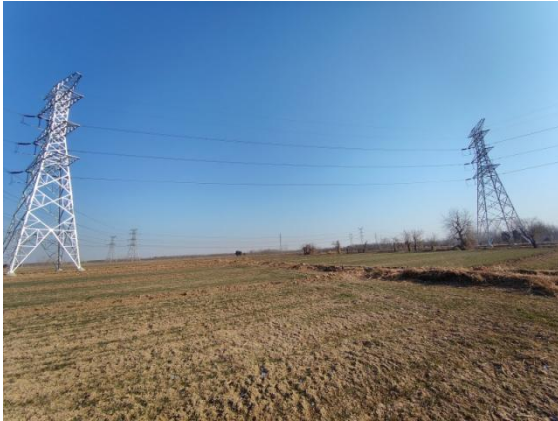
图 6-17 牵张场和临时道路周围临时占地恢复情况 1
