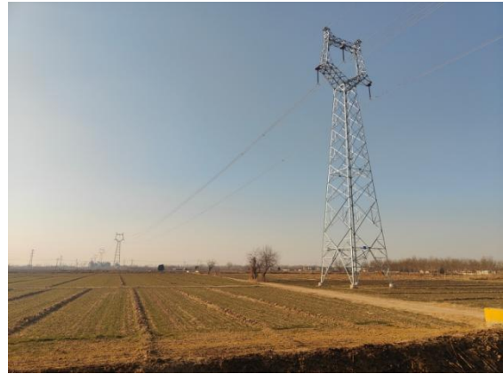
图 6-18 牵张场和临时道路周围临时占地恢复情况 2
