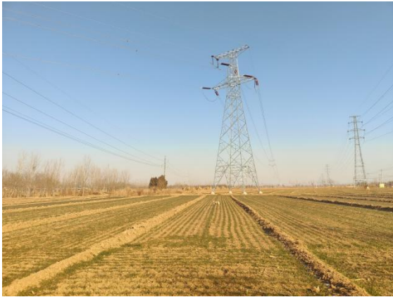
图 6-19 牵张场和临时道路周围临时占地恢复情况 3
