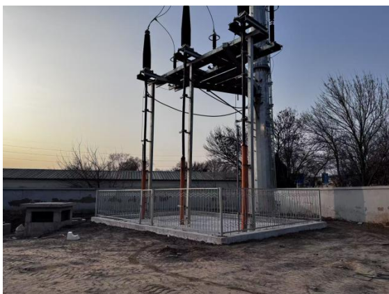
图 6-15 电缆隧道上方周围土地恢复情况
