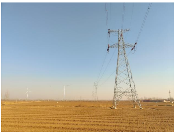
图 6-21 牵张场和临时道路周围临时占地恢复情况 5
