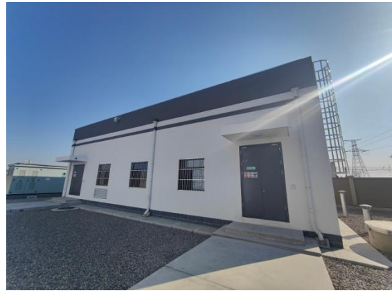
图 6-8 站内消防水泵房
