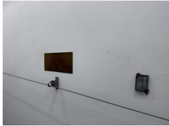
图 3-14 内部拉线开关
