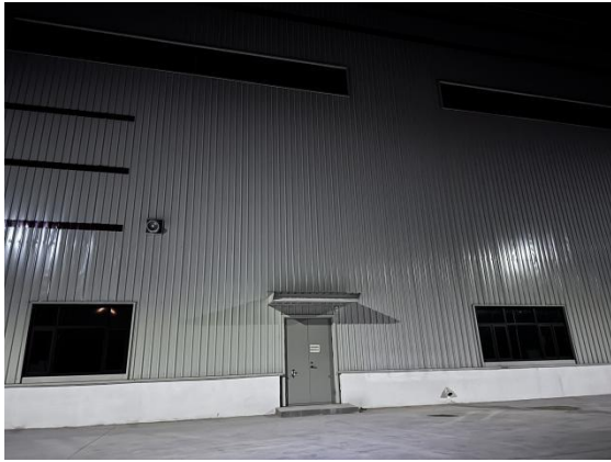
图 2-5 工业辐照加速器装置所在厂房
