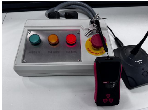
图 3-4 控制室紧急停机按钮、钥匙控制
