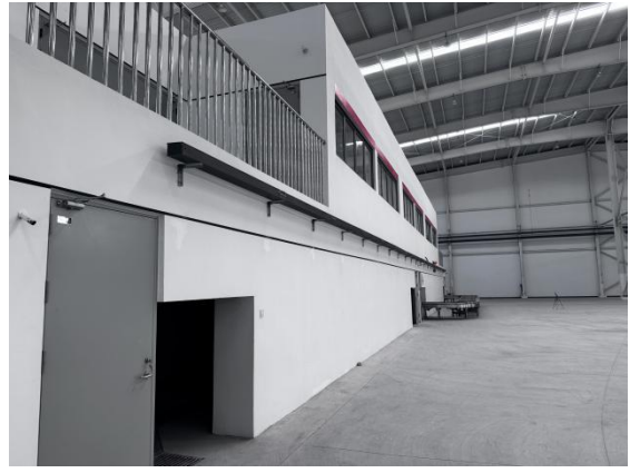
图 2-12 工业辐照加速器装置北侧 1#工业辐照加速器装置
