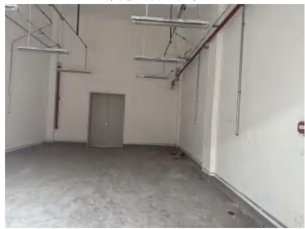
拟建 X 射线无损检测间西侧空房间
