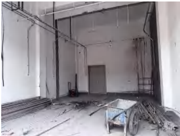
拟建 X 射线无损检测间现状
