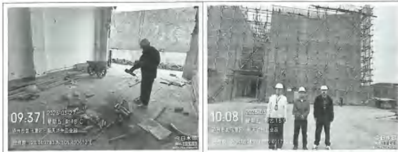
图 2 现场检测照片
