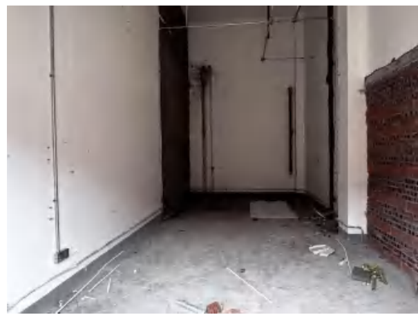
拟建控制室现状
