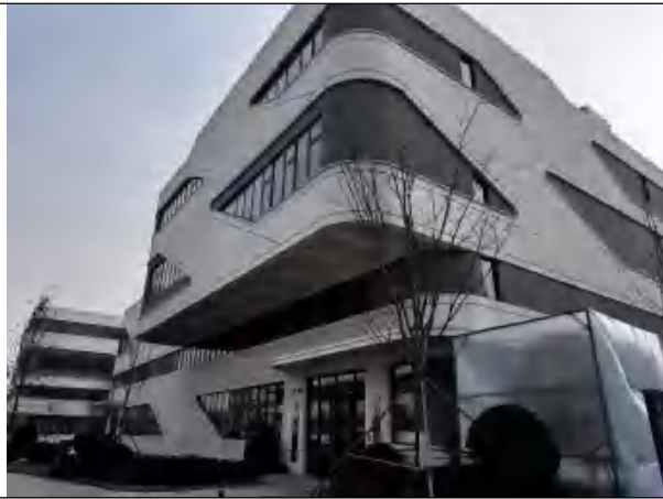
拟建加速器调试机房所在 16 号楼
