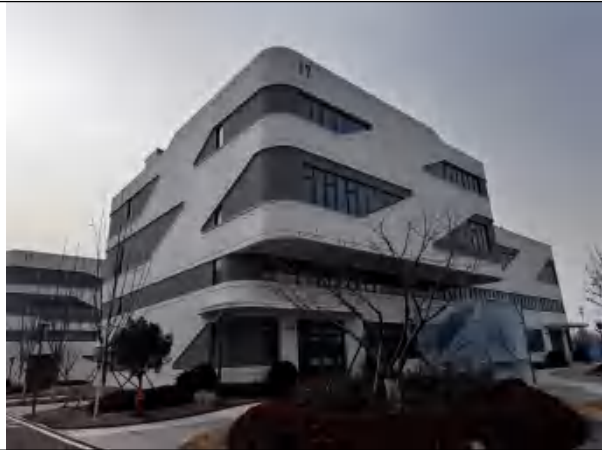
拟建加速器调试机房西侧 17 号楼
