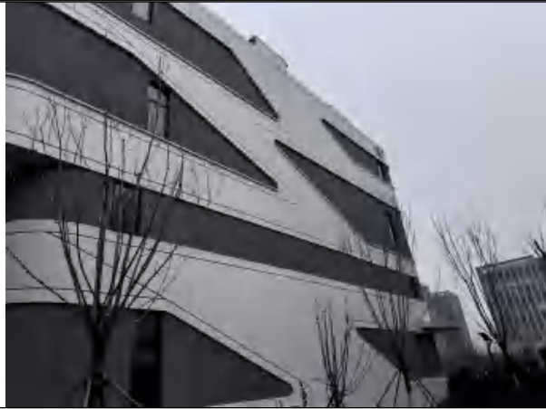
拟建加速器调试机房东侧 15 号楼
