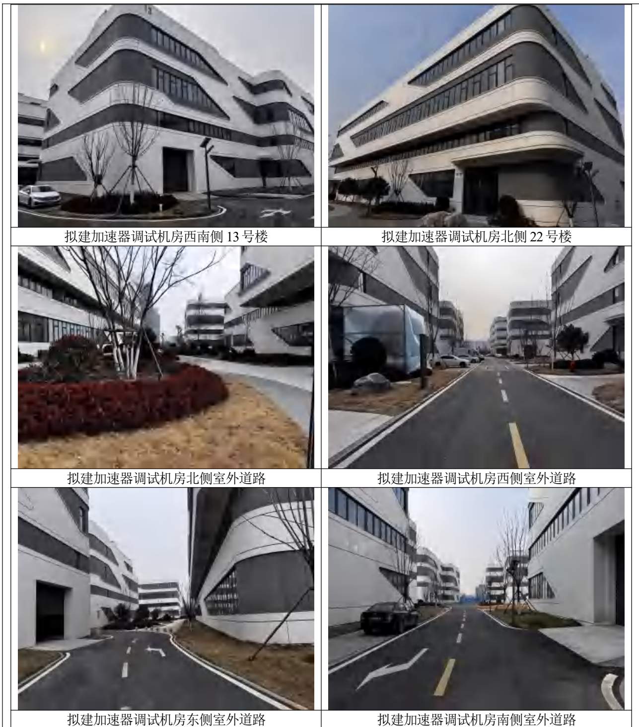
图 8-1 现场勘查现状照片（拍摄于 2026 年 1 月 6 日）
