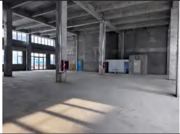
拟建加速器调试机房东侧 16 号楼 101 户
